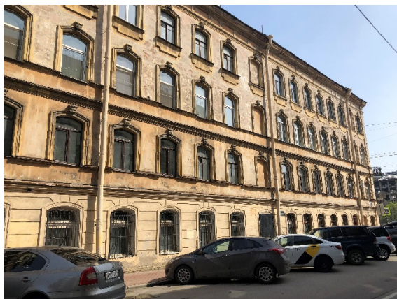
Фото № 19 – Фасад здания (ул. Егорова)
