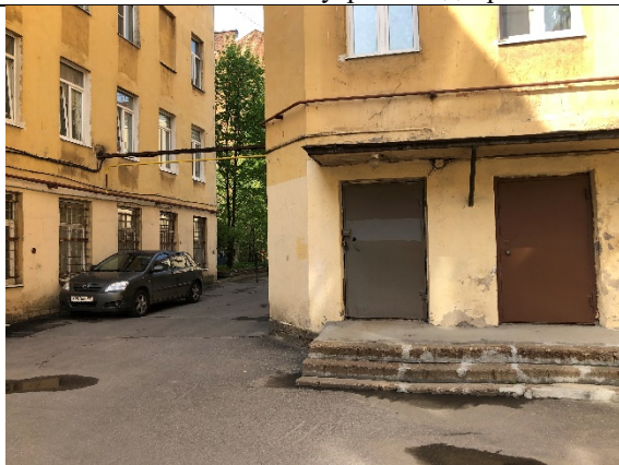
Фото № 15 - Проход к помещению с ул. Егорова
