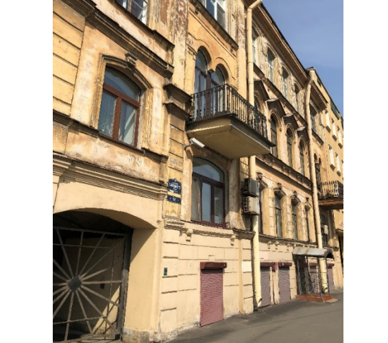
Фото № 20 - Фасад здания (наб. Обводного канала)
