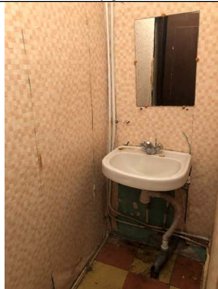
Фото № 10 - Внутренне состояние
