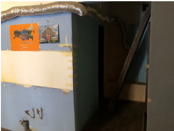
Фото № 9 - Внутренне состояние
