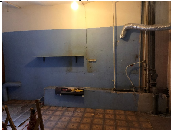
Фото № 6 - Внутренне состояние
