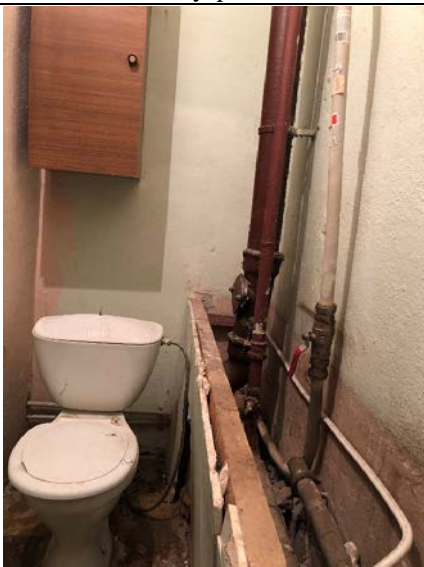
Фото № 11 - Внутренне состояние
