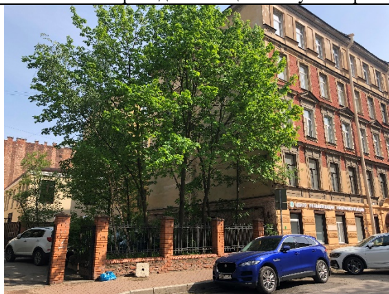
Фото № 18 - Проход к помещению с ул. Егорова
