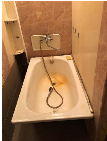
Фото № 12 - Внутренне состояние
