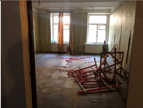
Фото № 7 - Внутренне состояние
