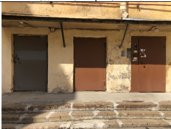
Фото № 2 - Вход в помещение
