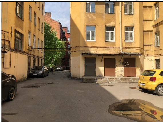
Фото № 1 – Вход в помещение
