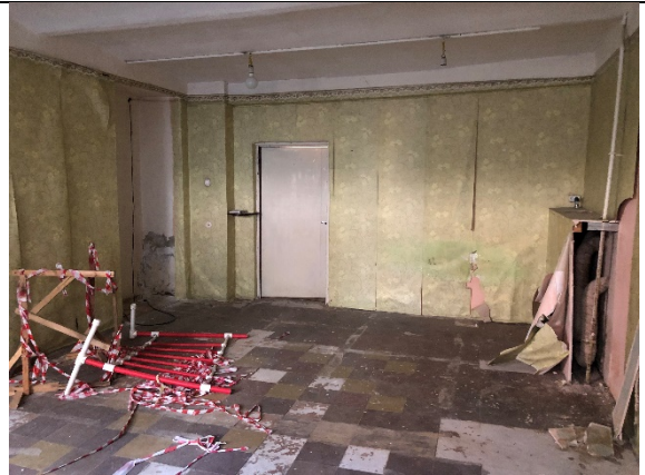
Фото № 8 - Внутренне состояние
